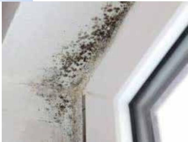
La muffa si forma nei punti freddi della casa nel caso in cui non venga fatta la giusta progettazione o non sia realizzato l'isolamento necessario tra il telaio e la muratura.
