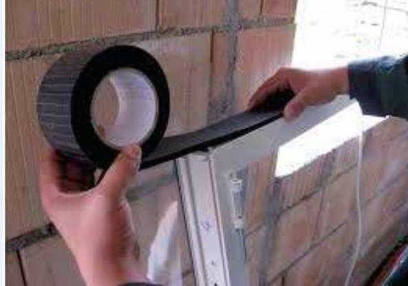
*Nastro usato tra finestra e falso telaio*
